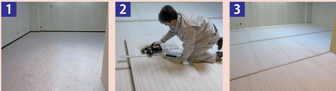
1 施工前(フラットな床:モルタル、コンパネ、フローリング、塩ビシート、タイル等) 2 ジムボードを丸のこ、ノコギリ等で必要なサイズにカットしてください。 3 設置部分にジムボードを敷き詰めてください。下地への貼り付けは不要です。
